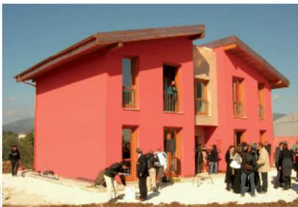
Edificio sperimentale per uffici dell'Università dell'Aquila.
